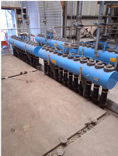
Modification filtre à manches
