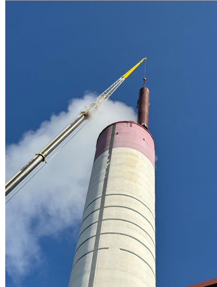
Changement des tubes cheminée
