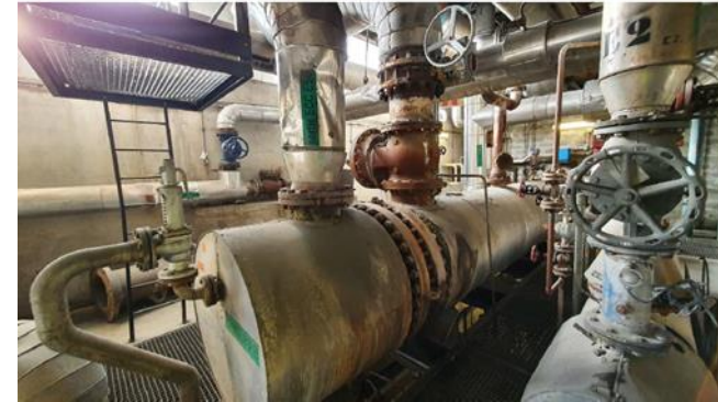
Echangeurs vapeur/eau surchauffée
