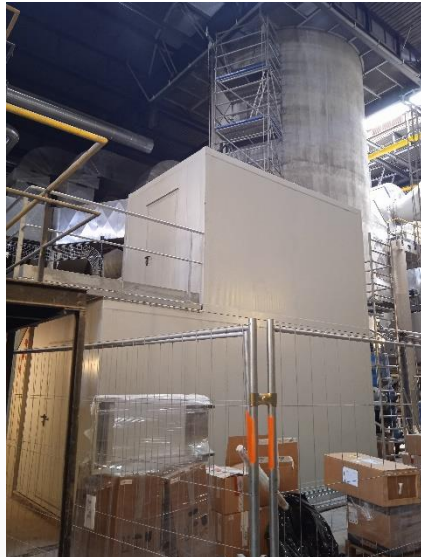
Mise en place des shelters en pied de cheminée
