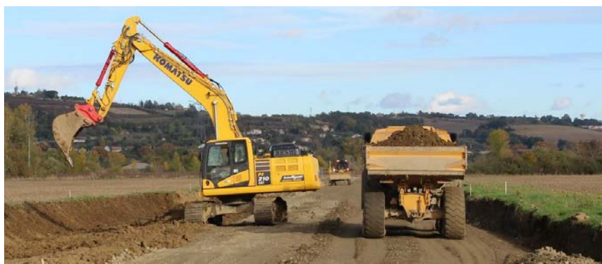
Travaux de contournement d'Ondes
